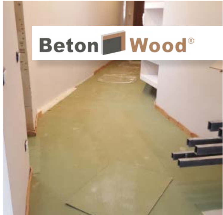
Posa del tappetino isolante in fibra di legno tipo Fibertherm® Underfloor nel sistema radiante sopraelevato Betonradiant®
